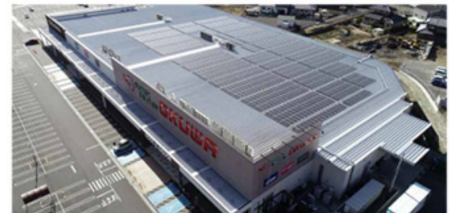
スーパーセンターオークワ多治見店屋上の太陽光パネル
